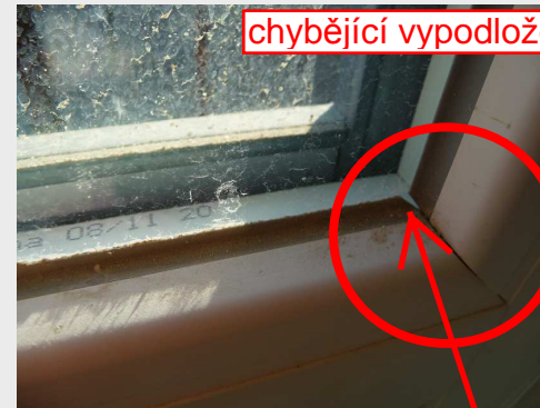
nedostatečné množství pěny a chybějící parobrzdná zábrana
