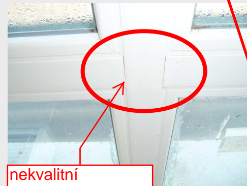
nekvalitní instalace vnitřního těsnění
