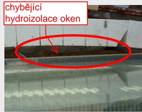
chybějící vypodložení oken
