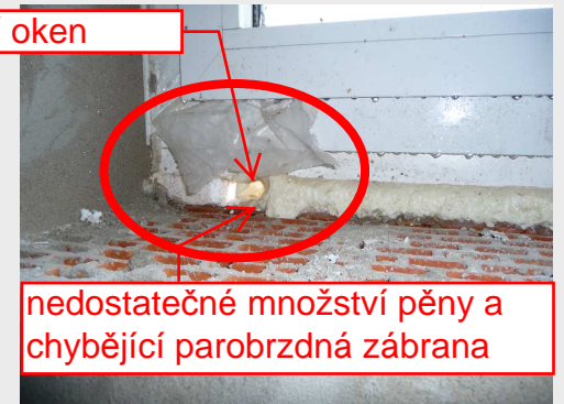
chybějící parobrzdná zábrana a utěsnění profilů
