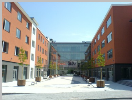
Avalon Plzeň 1.jpg
