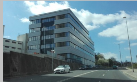
Kotelna Praha 5 (3).jpg
