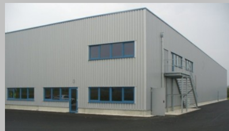
Hala TUP Cheb 2.jpg
