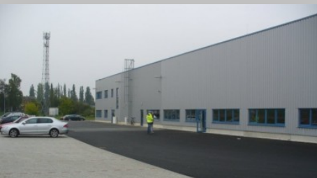
Hala TUP Cheb 1.jpg
