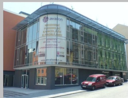
Avalon Plzeň 3.jpg
