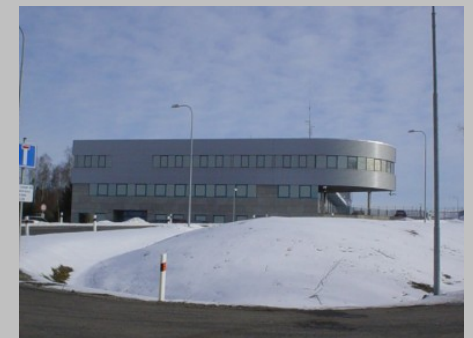
Hasičská stanice ČL.jpg
